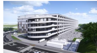
西宮北DC(新設)
