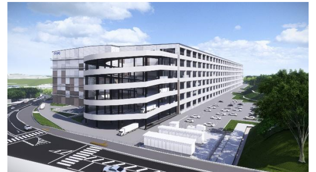
西宮北DC(新設)
